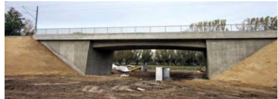
RC 2018 EÜ Flutbrücke Ausführungsplanung Bauform: Rahmenbrücke, Stützweite ca.30m
