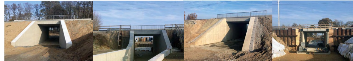
Erneuerung 4EÜ Großenhain Genehmigungsstatik Bauform: Rahmenbrücke, Stützweite zwischen 8-16m
